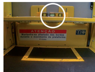
Ângulo de inclinação máximo de 3° em qualquer direção
