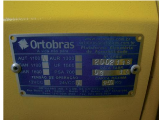
Plaqueta de identificação visível com nome e endereço do fabricante, mês, ano de fabricação, número de série, tensão de operação e capacidade máxima de carga
